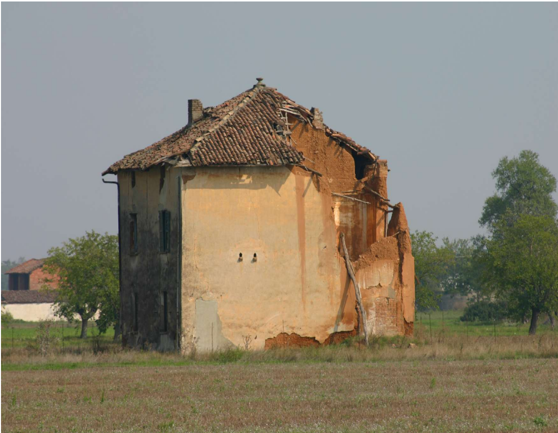
Rovina di una casa in terra battuta lungo al via Emilia Scauri.
