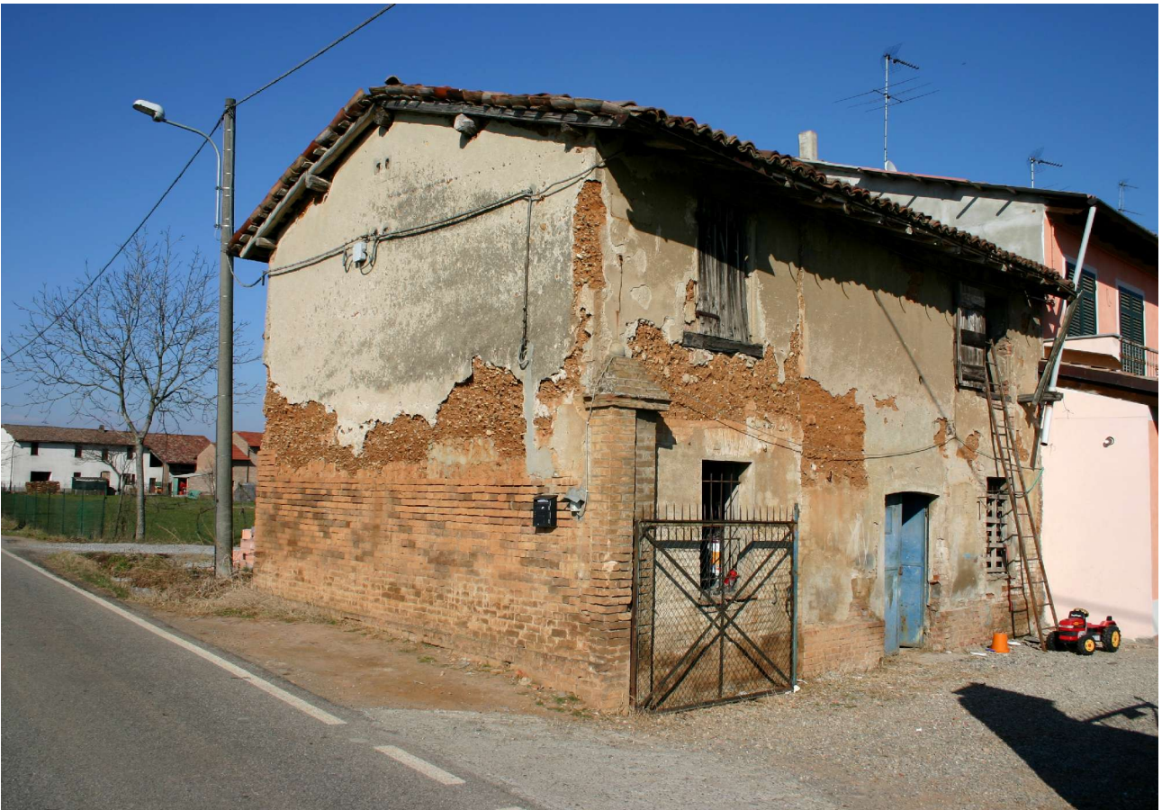
Casa in terra battuta a San Giuliano Vecchio.
