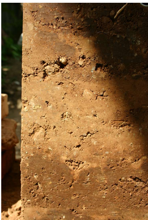
Esempio di compattazione di un setto in terra battuta, eseguito durante il laboratorio del corso “Costruire in terra cruda”, lug.2007.
